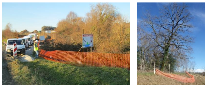
Figure 20 : Exemples de mises en défens sur un chantier
