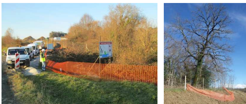
Figure 13 : Exemples de mises en défens sur un chantier
