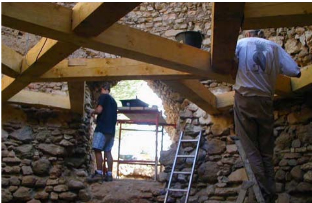
Chantier de jeunes pour la réhabilitation du patrimoine bâti
